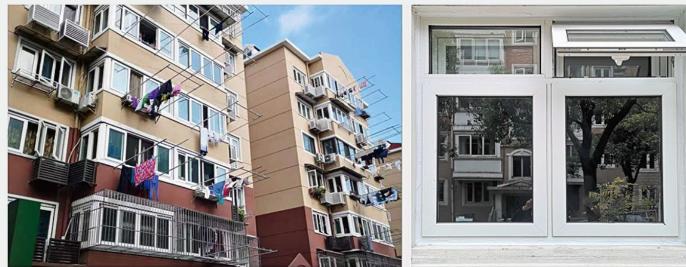
📍 上海虹桥机场噪声治理（隔声窗）改造工程
