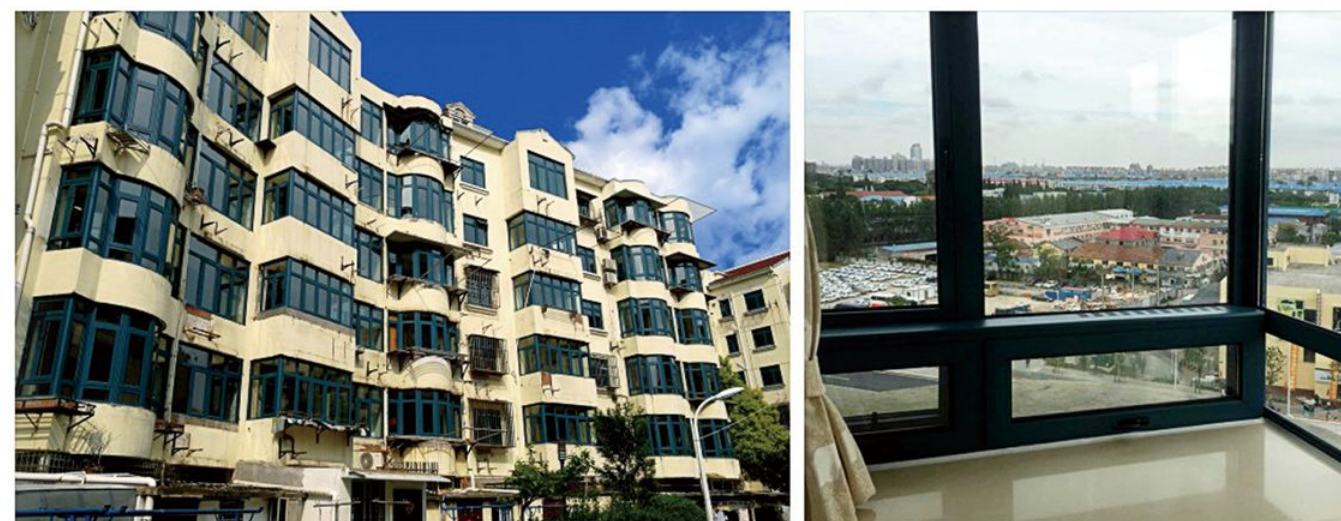
📍 浦东中环线噪声治理金杨路 985 弄小区（隔声窗）改造工程
