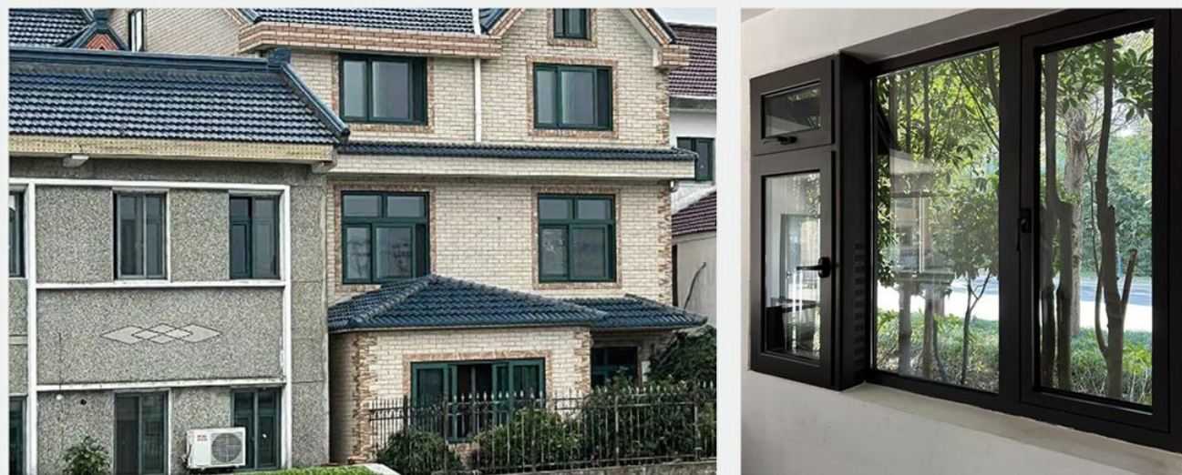
📍 平申线金山段金枫大桥噪声治理（隔声窗）改造工程
